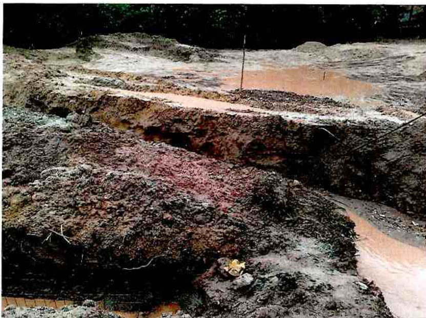
Quebrada en proceso de canalización.
