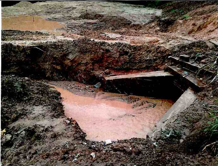
Box couvert, ubicado a la entrada del predio. Luego de atravesar la autopista.
